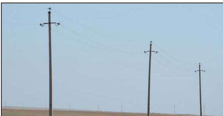
Участок птицеопасной ЛЭП, оснащённый ПЗУ. Фото В. Вороновой.
