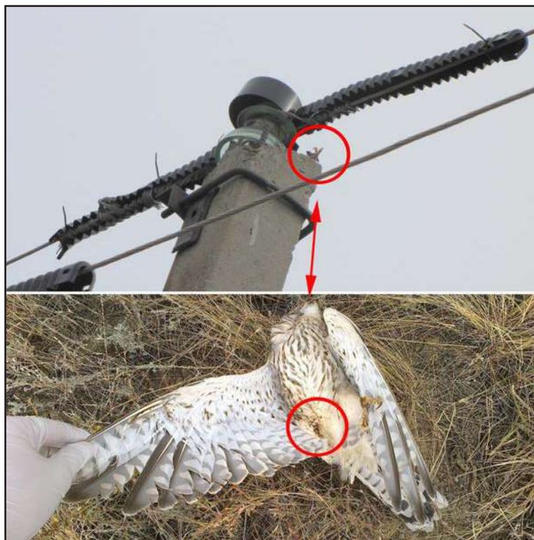
Траверса, некачественно оснащённая ПЗУ, под которой обнаружена мёртвая пустельга ( Falco tinnunculus ), поражённая электрическим током. Фото В. Вороновой.
