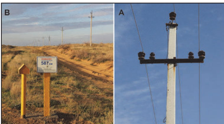
Рис. 3. А – оголовок опоры ВЛ «Газпром трансгаз Ставрополь» (трубопровод Мака́т-Северный Кавказ), В – ВЛ катодной защиты трубопровода АО КПК. Астраханская область, РФ, 11.10.2011. Фото М. Пестова.
