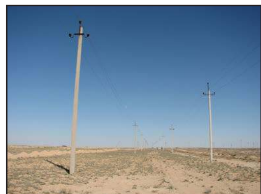
Рис. 2. Линии электропередачи 6–10 кВ вдоль магистрального газопровода «Средняя Азия – Центр».
