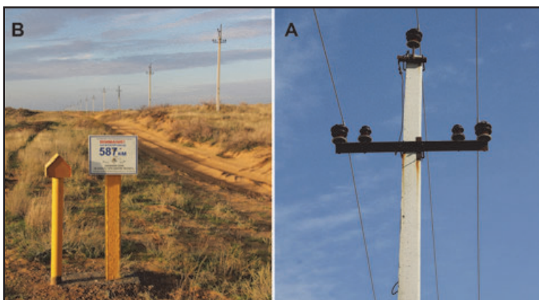
Рис. 3. А – оголовок опоры ВЛ «Газпром трансгаз Ставрополь» (трубопровод Мака́т-Северный Кавказ), В – ВЛ катодной защиты трубопровода АО КТК. Астраханская область, РФ, 11.10.2011. Фото М. Пестова.
