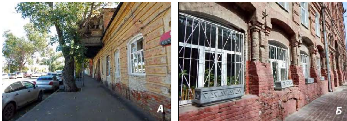
Рис. 2. Характерные места обитания T. caspius в г. Астрахань: А – старинные жилые здания по Набережной р. Кутум; Б – кирпичное здание с обширными подвальными помещениями по ул. Советской Милиции (фото А.В. Андреева)
